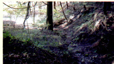
●リニア実験線のトンネル工事による沢涸れ （山梨県笛吹市御坂町）
