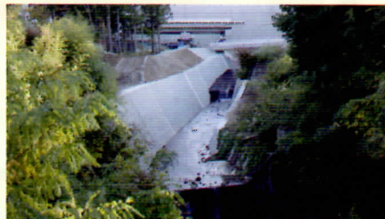
●リニア実験線のトンネル掘削で異常出水 導水路で川に流している（山梨県笛吹市御坂町）
